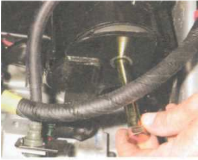
Вынимаем болт крепления опоры к кронштейну.
